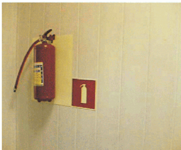
Рисунок А.7 — Вариант обозначения огнетушителя с использованием фотолуминесцентного экрана
